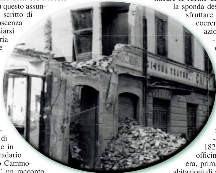
Sotto le macerie di questa casa costruita sul ponte dell'Aera più in basso del livello stradale è situato un locale che probabilmente ha accolto una fucina di fabbro nel Medioevo
