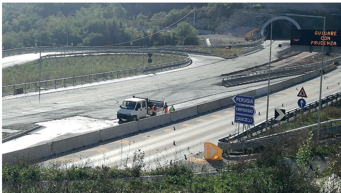
I lavori all'altezza dello svincolo per Sassoferrato, Cancelli e Campodiegoli, prossimo all'apertura
