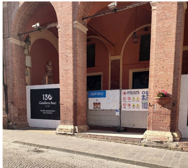
La futura sede della Gioielleria Pesci: i lavori sono in corso
