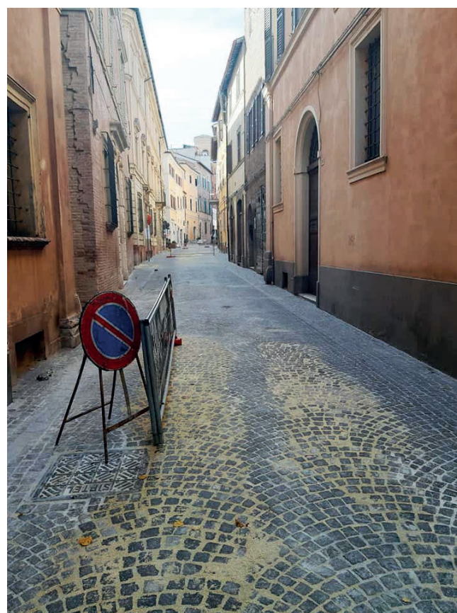
Sopra: i lavori in via Cialdini
