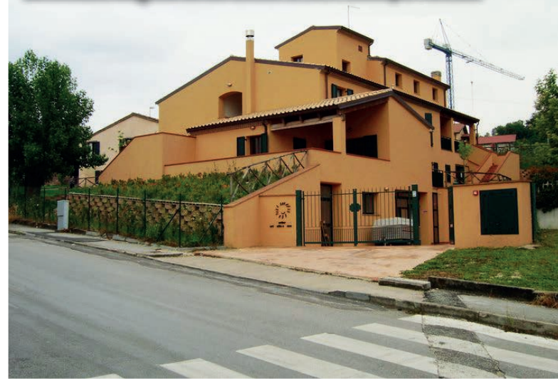
La struttura composta da due moduli abitativi distinti, in via Sassi
